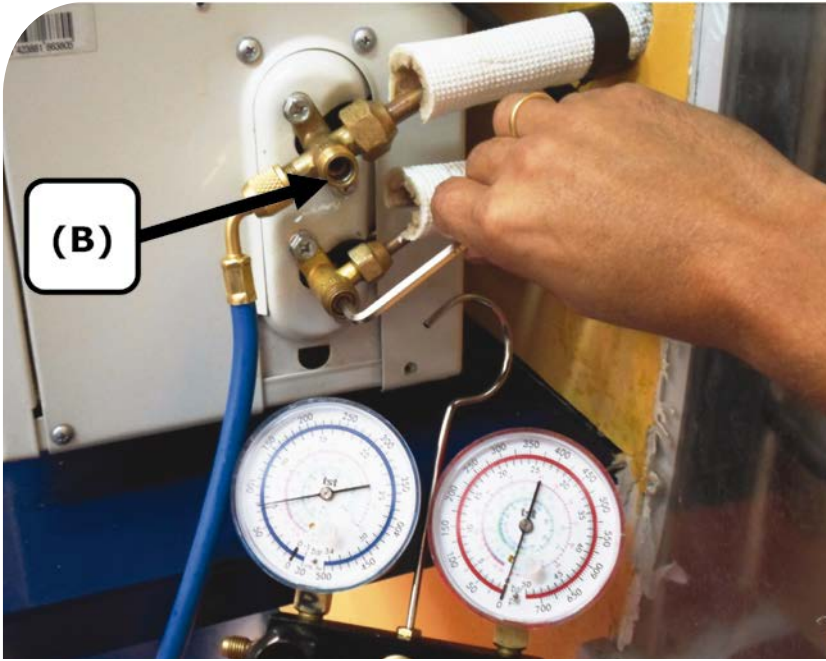
Foto 17. Método de recuperación de refrigerante en el propio equipo.
