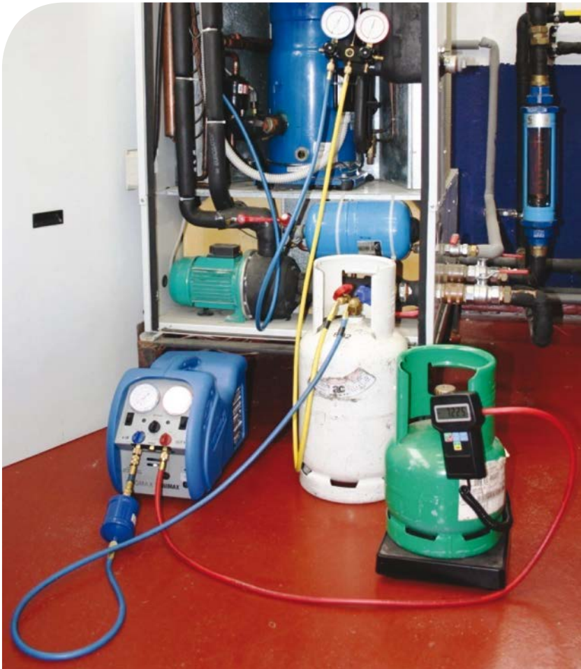
Foto 19. Recuperación de refrigerante en estado líquido.
