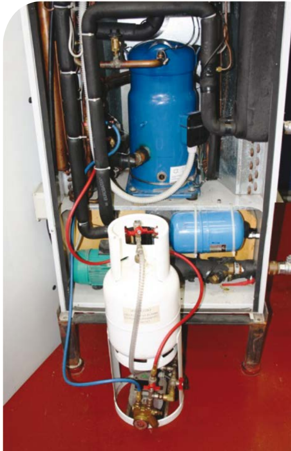
Foto 10. Limpieza del circuito frigorífico.
