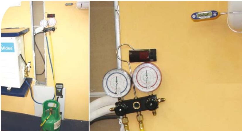
Foto 15. Método de carga por recalentamiento.
