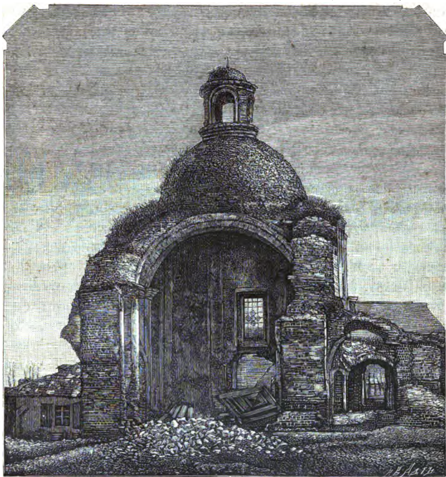
Развалины Крестовоздвиженской церкви въ г. Луцкѣ. (Съ западной стороны).
